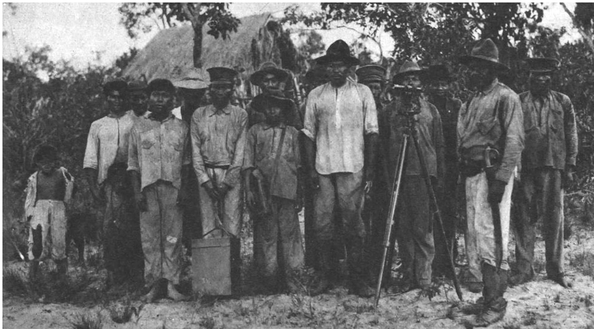
Fotografia 4 – Indígenas Kaiowá e Terena: trabalhadores na construção do ramal da linha telegráfica até Ponta Porã.
